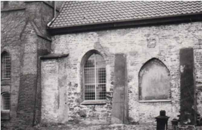
Als bei Bauarbeiten im Jahre 1966 der Putz von den Außenmauern der Kirche abgeschlagen wurde, konnte man kurzzeitig sehr gut erkennen, dass ein Teil des Mauerwerks unterhalb der Fenster ursprünglich aus metallhaltigem Raseneisenstein erbaut worden war und später lediglich durch Backstein im Klosterformat ergänzt wurde. Nachweislich stammen diese Teile des Gemäuers noch aus der Zeit eines Vorgängerkirchenbaus an gleicher Stelle. Die im Mauerwerk und durch Ausgrabungen nach-
